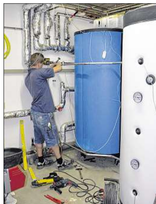
PARALLEL laufen der Heizungsumbau und die Anschlussarbeiten im Keller. Foto: kec
