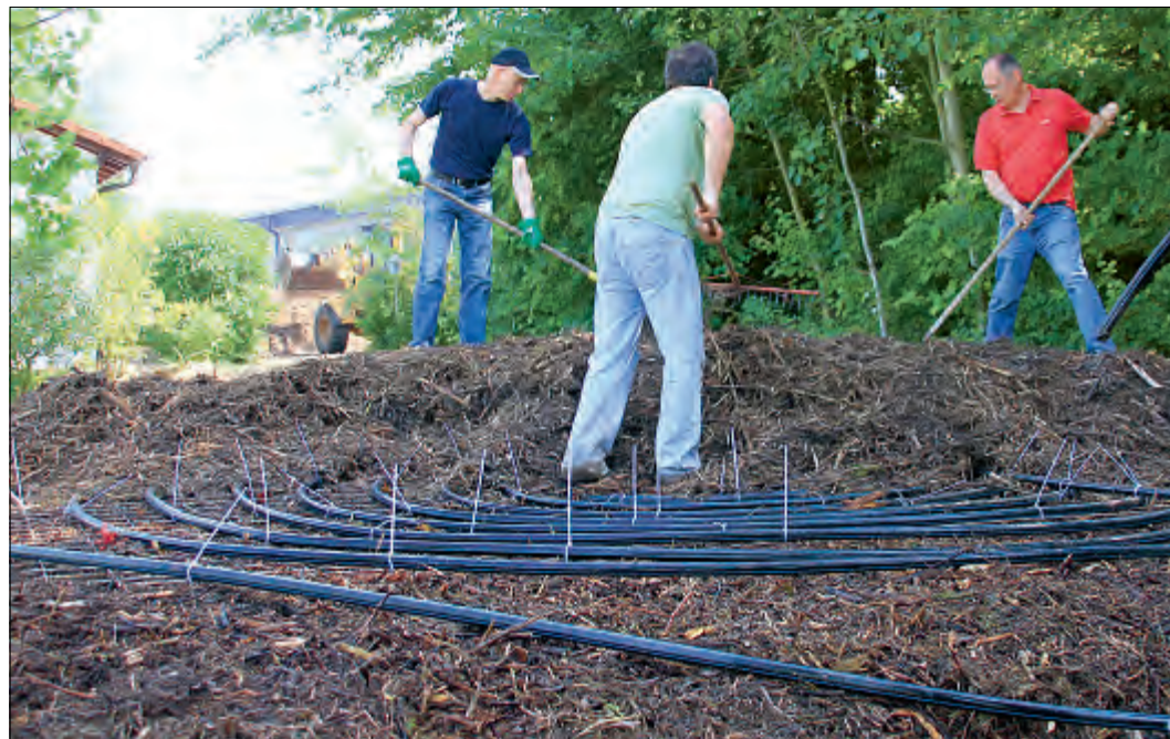
Schichtweise wird der Biomeiler errichtet. Nach einer 50 bis 70 Zentimeter hohen Schicht Schnittgut folgen jeweils die Rohrleitungen.
